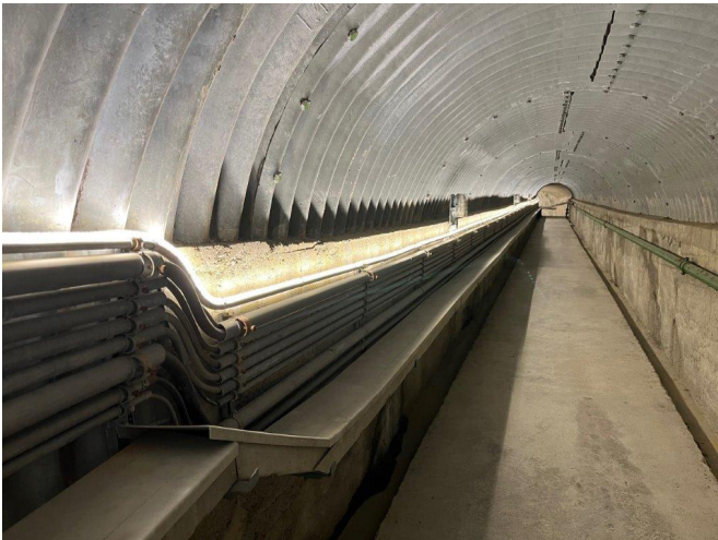
Dam wall Grande-Dixence
